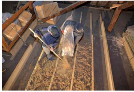
Der Dämmstoff ist sorptionsfähig, das heißt, er kann Feuchtigkeit aufnehmen und wieder abgeben. Deshalb sind über dem Dämmstoff keinerlei Folien und Dampfsperren notwendig
