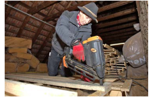
Der Bodenaufbau wird stabil, wenn der Dielenboden auf den Sparrenexpandern vernagelt ist. Eine Schalung verlegten die Handwerker nur dort, wo Laufwege vorgesehen waren
