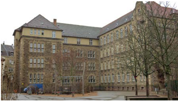
Die Vogesenschule, Baujahr 1908, hatte einen ungedämmten Dachboden. Nun wurde die oberste Geschossdecke gedämmt
