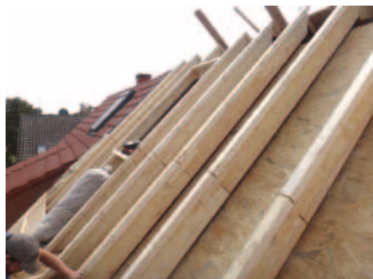
Beispiel Dacherrhöhung mit UE 145
