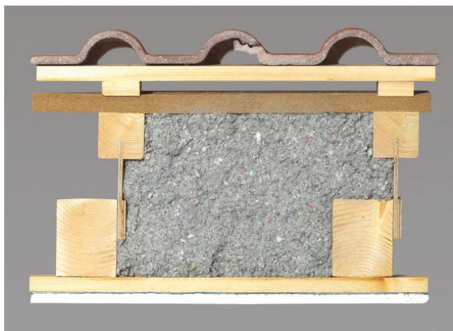
Der Sparrenexpander: schlanke Sparren – dicke Dämmung
