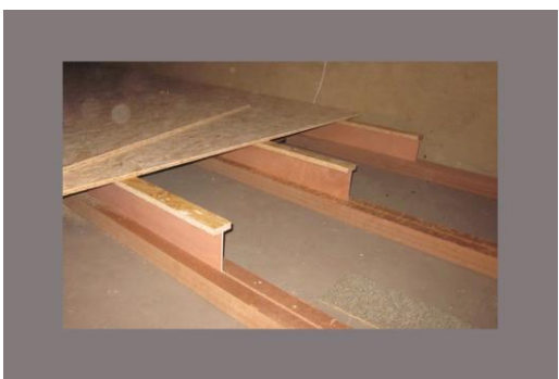
DP mit SE und OSB-Boden
